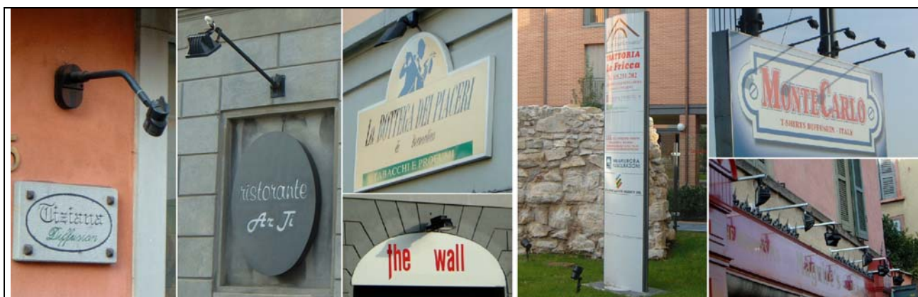
Fig.17 – Esempi di insegne prive di illuminazione propria. Le tre insegne di sinistra sono conformi alla L.r.17/09 in illuminante dall'alto verso il basso con apparecchi orizzontali o inclinati ma con flusso intercettato dalla parete. A destra 2 insegne non conformi alla L.r. 17/09 in quanto la prima è illuminata dal basso e il pannello pubblicitario è illuminato dall'alto ma con corpi illuminanti inclinati con flusso non intercettato dalla sagoma.
