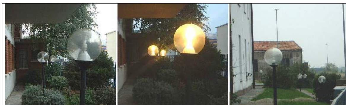
Fig.22 – Nelle 2 foto di sinistra l'illuminazione è in deroga in quanto ho 3 punti luce non schermati: sfere con lampade a fluorescenza compatte da max 23W (1500 lumen massimo ciascuno). In caso di più di 3 punti luce, si sarebbe dovuta verificare l'emissione effettiva oltre i 90° (non superiore complessivamente a 2250 lumen) in quanto il terrazzo soprastante li schermava solo in parte. Nella foto di destra la deroga non è applicabile. Appaiono infatti 5 punti luce che, anche se dotati ciascuno di lampade a fluorescenza compatte da max 23W (1500 lumen massimo ciascuno) hanno comunque un'emissione massima oltre i 90° superiore complessivamente a 2250 lumen. Se fossero state schermate adeguatamente (con emissione max complessiva di 2250 lumen verso l'altro) sarebbero state in deroga.
