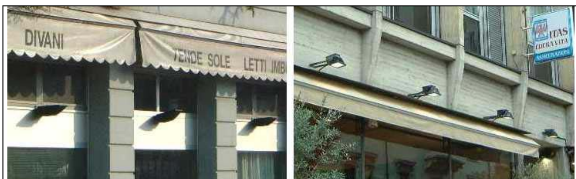
Fig.24 – Nella foto di sinistra una vetrina illuminata erroneamente dal basso verso l'alto. In quella di destra invece l'illuminazione è conforme alla LR17/00. Se la vetrina di destra fosse conforme non necessiterebbe né di progetto né di autorizzazione dell'autorità competente ai fini della conformità alla LR17/00. In alto appare un insegna in deroga alla LR17/00 in quanto a luce propria.
