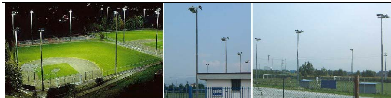
Fig.12 - Impianti sportivi illuminati in modo conforme alla L.R.17/00 con proiettori asimmetrici orientati orizzontalmente e che non disperdono luce verso l'alto.
