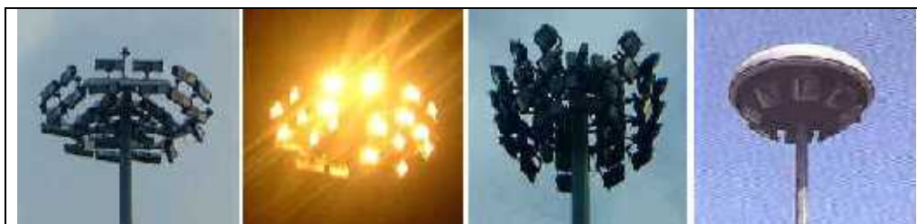
Fig.2.3 – Torri faro "palesemente" inquinanti. Nell'ultimo impianto a destra infatti, il cappello ha l'unico obiettivo di proteggere gli apparecchi d'illuminazione dalle intemperie.
