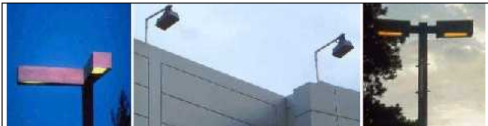
Fig.11 – Nelle foto sono evidenziati alcuni apparecchi per illuminazione stradale, di parcheggi e capannoni industriali. Le lampade utilizzate nelle tre foto sono al sodio BP completamente full cut-off a vetro piano orizzontale. In ogni caso l'illuminazione degli edifici di non rilevante valore artistico, storico architettonico deve avvenire solo dall'alto verso il basso.
