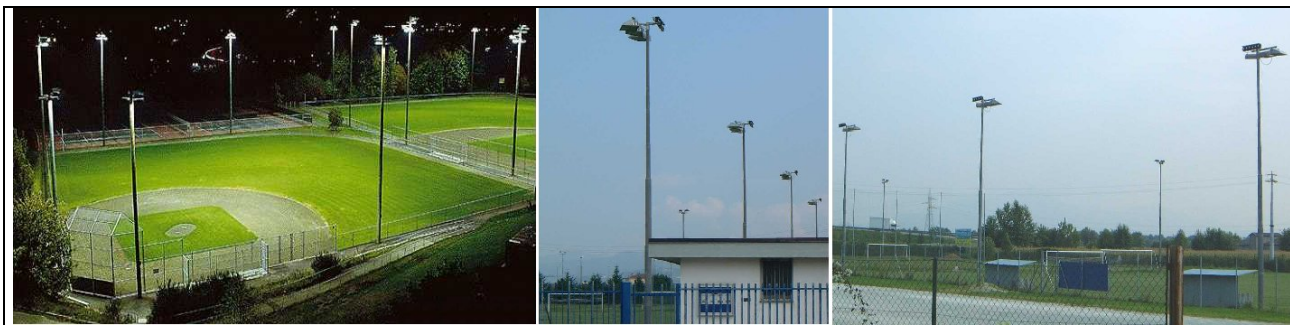
Fig. 3.2 – Impianti sportivi illuminati in modo conforme alla L.R. 15/05 con proiettori asimmetrici orientati orizzontalmente e che non disperdono luce verso l'alto.
