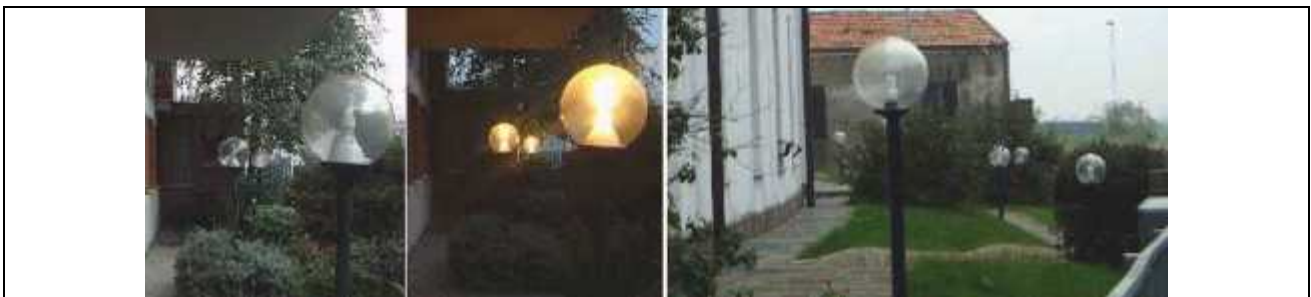
Fig.9 – Nelle prime due foto di sinistra l'illuminazione è conforme alla deroga in quanto sono installate 3 lampadine da 18W fluorescenza compatta (flusso totale emesso 1200lumen) per un flusso emesso verso l'alto di circa 1800lumen. Nella foto di destra l'impianto è fuori legge in quanto le 5 lampade a fluorescenza compatta da 18W (1200lumen) emettono circa 3000 lumen verso l'alto.
