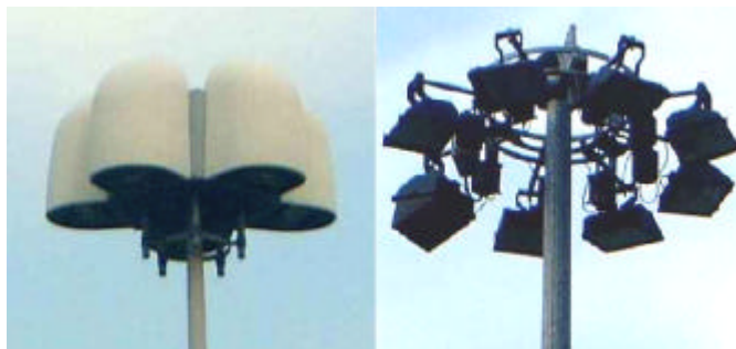
Milano - L'utilizzo di fari asimmetrici permette di costruire torri faro totalmente schermate anche di notevoli dimensioni. Nella foto di destra si ha avuto l'accortezza di limitare (la dove non serviva) il flusso luminoso con degli schermi applicati sul riflettore (D.Bonata)
