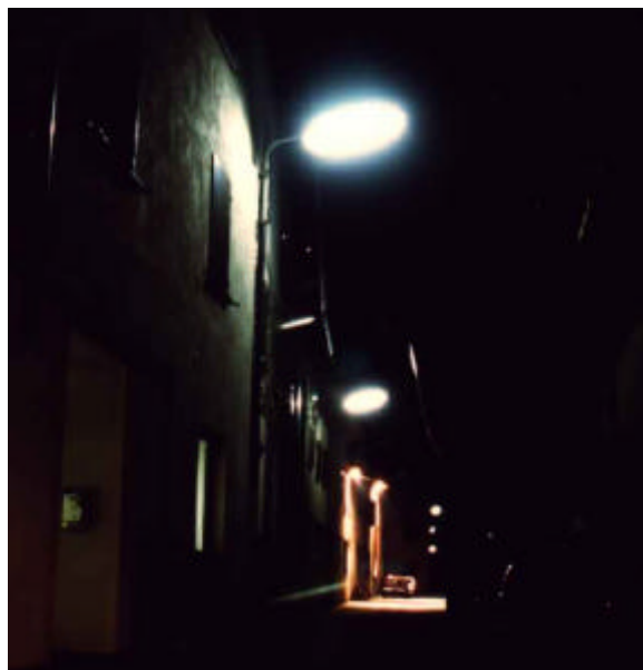
Suisio - Un pessimo esempio di doppio impianto: in primo piano lampade a fluorescenza non illuminano la strada ma le finestre circostanti, e sullo sfondo un impianto giustamente full cut-off al sodio ad alta pressione ma sovradimensionato per le effettive esigenze della strada. (G.Agostoni).
